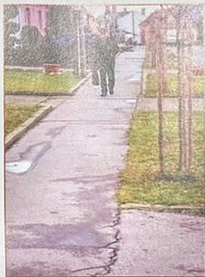
Chodníky pred rekonštrukciou
