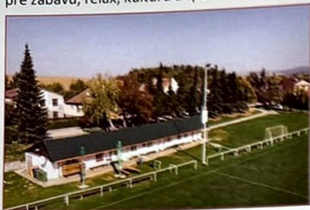
Šatne na futbalovom ihrisku aj s prístupovým chodníkom po rekonštrukcii
