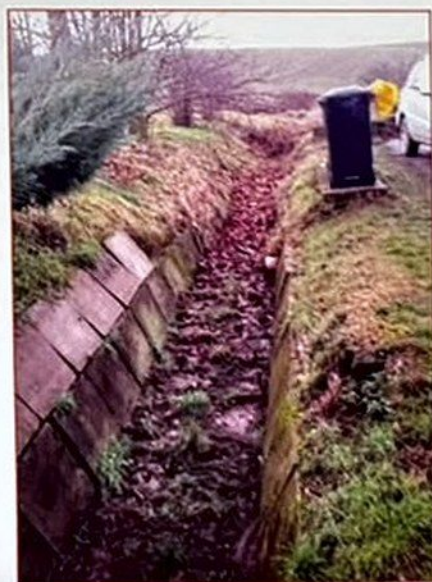
Odvodňovací rigol pred rekonštrukciou
