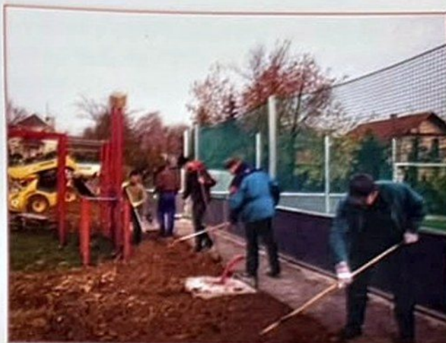
Brigáda Rybčanov pri výstavbe ihriska s umelou trávou
