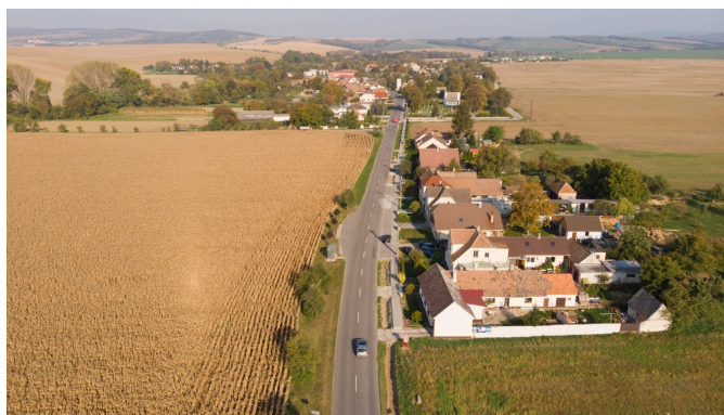
Chodník takmer cez celú obec. Postavený vďaka spolufinancovaniu, ktoré sme získali – bezpečná cesta pre deti aj seniorov.
