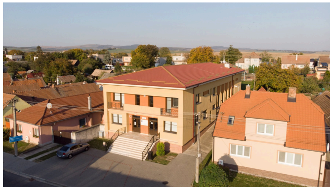
Kultúrny dom. Na rekonštrukciu sme získali 262 300 € a zariadili aj novú kuchyňu. Služí obci a jej spolkom – nie je na dlhodobý prenájom s nejasným účelom súkromnej firme.
